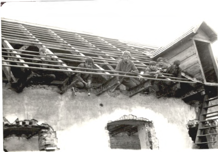
A kibontott ajtók és ablakok tégláinak letakarítása.
